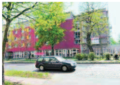
Vorn rot, an der Seite gelb – im Schatten der Laga-Baustellen ist das Seniorenhaus fast fertig geworden. FOTO: ENRICO KUGLER
