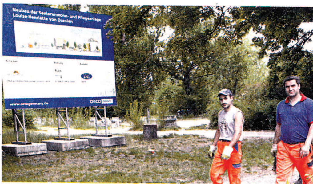
Seit einigen Tagen kündigt eine Infotafel vom bevorstehenden Baugeschehen. Nach dem ersten Spatenstich wird die Anmeldeleiste eröffnet, so der Bauherr.
