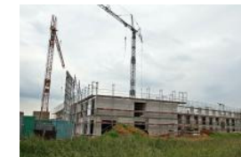
Der Rohbau der Seniorenwohnanlage „Burgresidenz Luidgard“ in Staufenberg.
