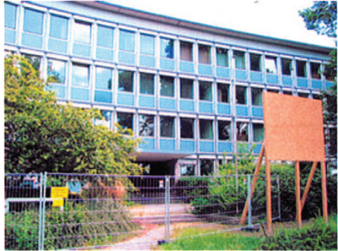
Noch strahlt die Immobilie den Charme eines in die Jahre gekommenen Bürokomplexes aus. Eine Berliner Unternehmensgruppe verwandelt das Gebäude in ein Seniorenheim. Foto: Kröger
